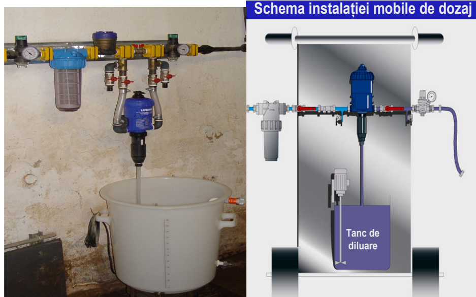
Fig. 4.3. Sistem mobil de administrare a medicamentelor model Dosatron® pentru administrări la porci
