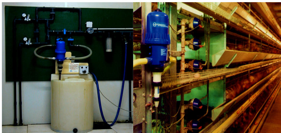
Sistemul fix de administrare a medicamentelor Dosatron® (2) pentru administrări la păsări
