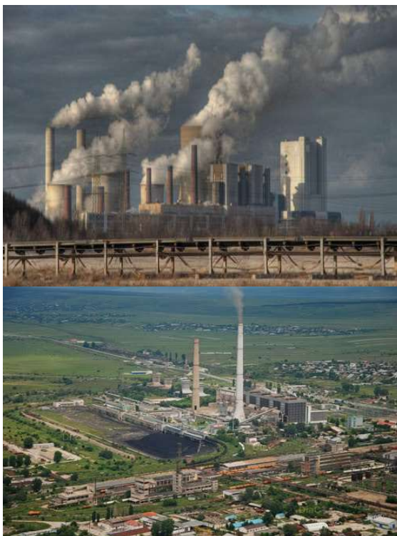
Figura 2. Imagini ale termocentralelor Turceni (Gorj) și Eșalnița (Dolj) [19, 20].
